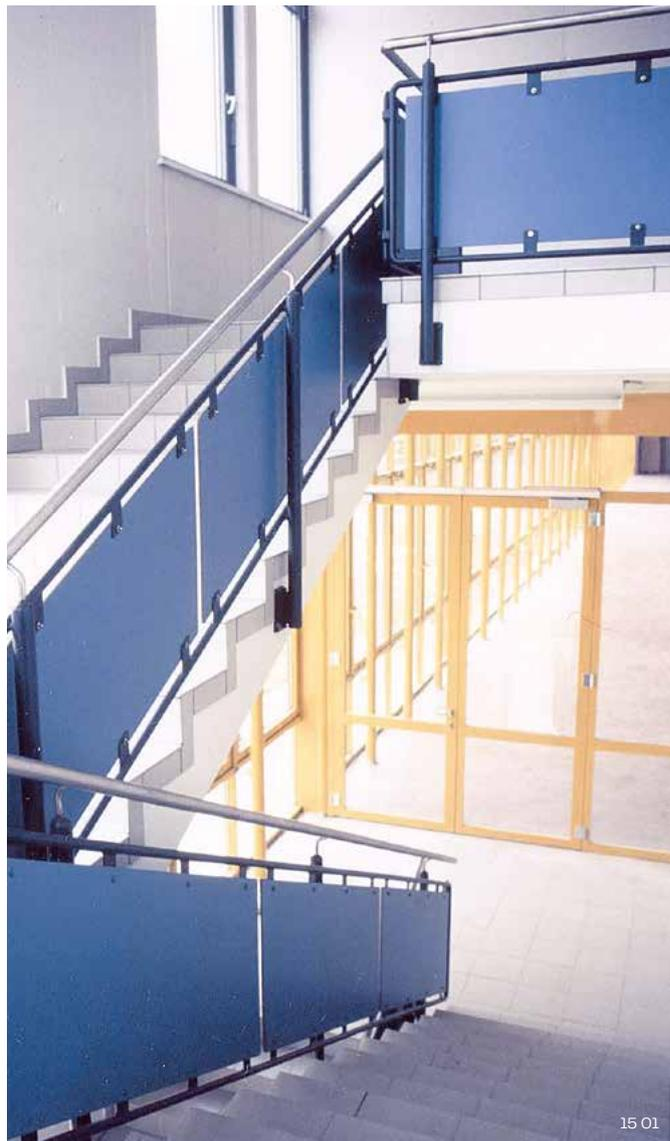
15 01 Geländerfüllung mechanisch befestigt
