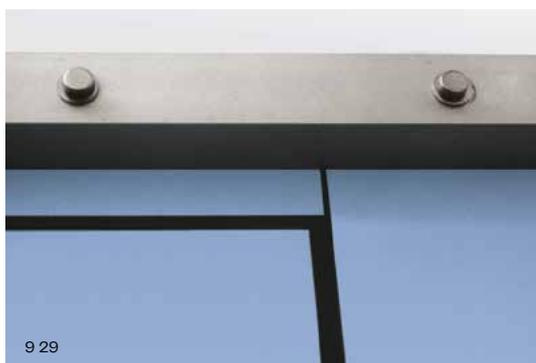
Zum Verbinden von Max Compact Interior Platten; Plattendicke für Trennwände: 13,0 mm
